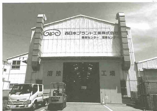
写真12 配管製作などを行う溶接センターA棟
