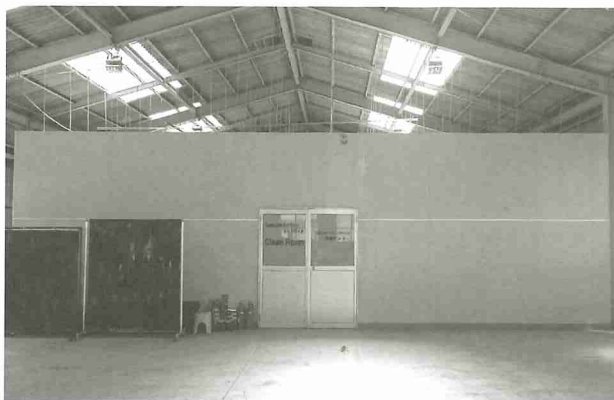
写真6 半導体工場用真空管を製作するクリーンルーム
