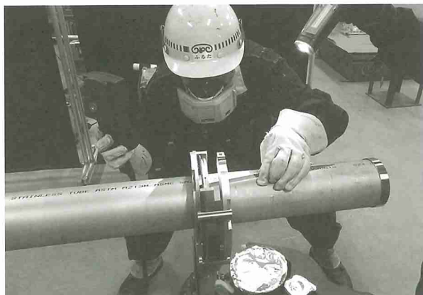
写真9 溶接ヘッドのセッティング
