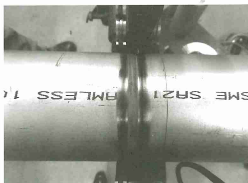
写真11 溶接終了後のビード外観
