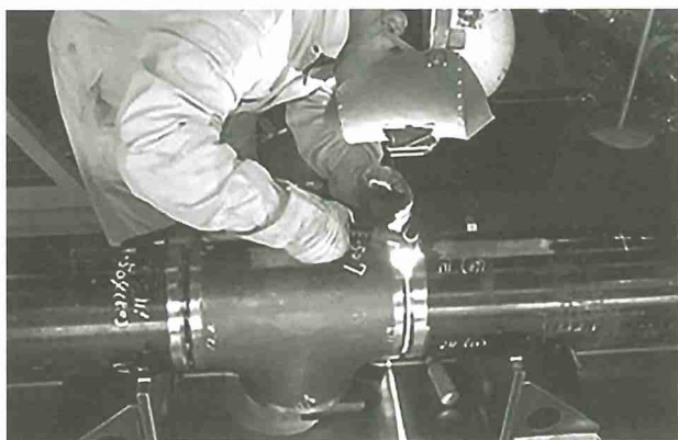
写真15 配管プレファブの製作
