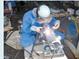
▲溶接箇所が2万箇所にも及んだハロン配管溶接作業
