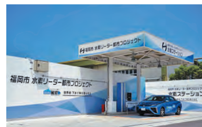
▲福岡市中央区荒津にある水素ステーション
