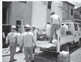
▲持参したスポットクーラーの荷卸し
